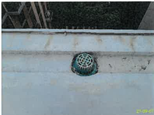
หัวรับน้ำฝนจากชั้นหลังคาอาคาร A
