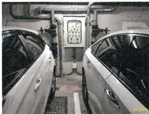
บ่อรับน้ำฝนชั้นใต้ดิน และตู้ควบคุม ตัวที่ 2
