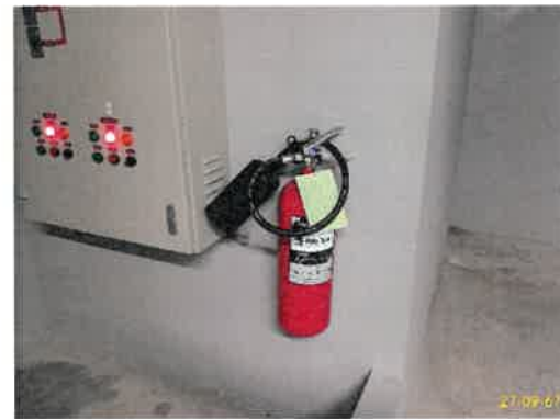
เครื่องดับเพลิงแบบมือถือชนิด CO 2
